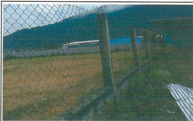
Foto 2: Remozamiento de cerco o Muro Perimetral
