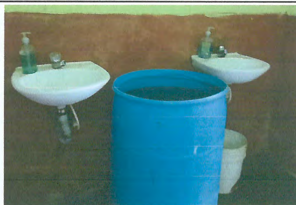
Foto 4: Servicios Sanitarios y sus accesorios.
